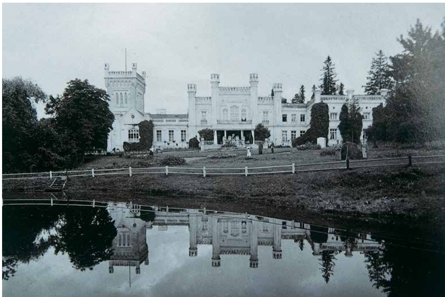
Vaitkuškio rūmų vaizdas iš sodo pusės. 1902 m. NMKČDM fotografijų rinkiniai, Ta-5234.
